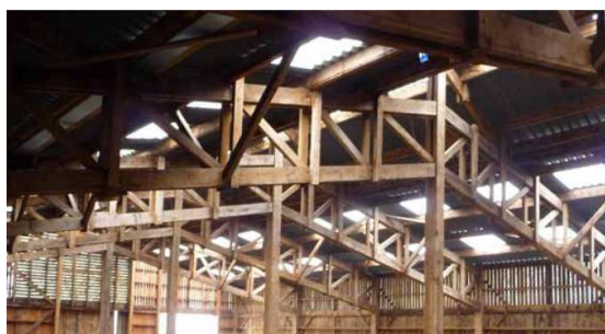
Charpente en Chêne
